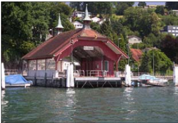
Haltestelle «Seeburg» der Schifffahrtsgesellschaft Vierwaldstättersee (SGV) in der Mitte des Untersuchungsperimeters.
