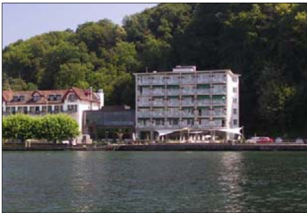
Ufersituation Transekt 2 (Seesicht). Hotel Seeburg.
