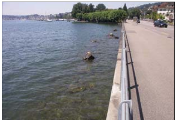
Ufersituation Transekt 3 (Blick Richtung Nordwesten, entlang der Seestrasse nach Würzenbach). Im Hintergrund Areal des Bootshafen Seeburg Yachtclub.
