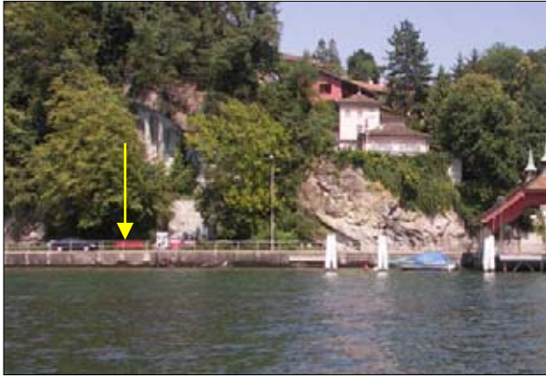
Einleitungsbauwerk der Regenentlastungsanlage bei Transekt 4 (Pfeil). Im Bild rechts die SGV-Haltestelle «Seeburg».
