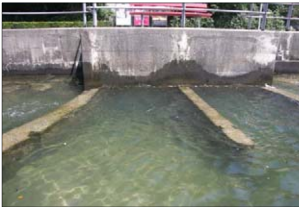
Detailansicht des Einleitungsbauwerkes mit den 3 seeseitigen Leitmauern.
