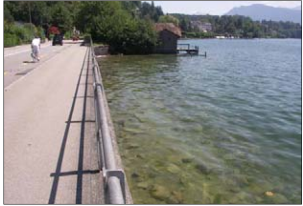
Ufersituation Transekt 7 (Blick Richtung Südosten, entlang der Seestrasse nach Hermitage)
