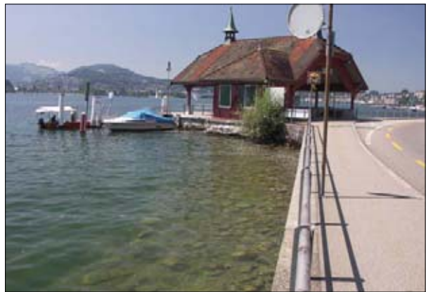
Ufersituation Transekt 5 (Blick Richtung Westen).
