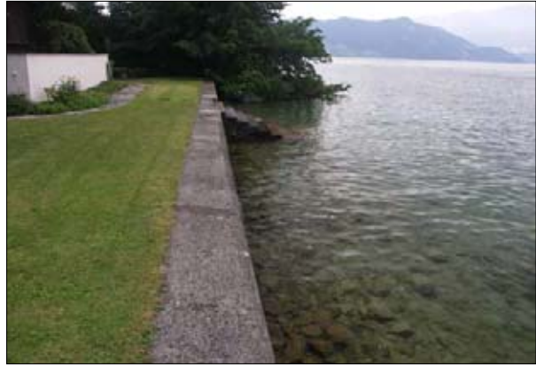
Ufersituation Transekt 10 (Blick Richtung Südosten).
