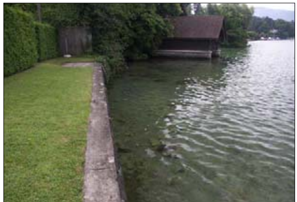
Ufersituation Transekt 9 (Blick Richtung Südosten).
