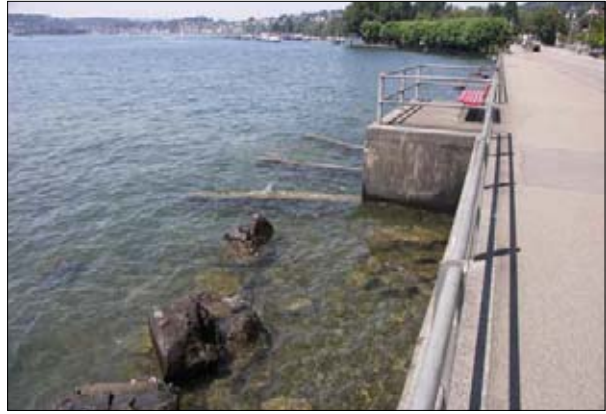
Ufersituation Transekt 4 (Blick Richtung Nordwesten, entlang der Seestrasse nach Würzenbach). Im Vordergrund Einleitungsbauwerk der Regenentlastungsanlage.
