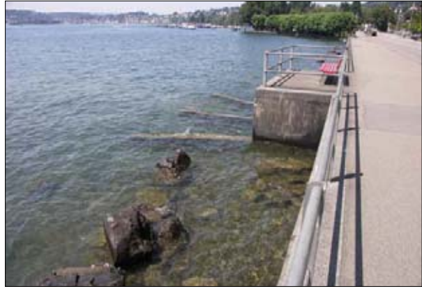
Einleitungsbauwerk, Sicht von der SGV-Haltestelle entlang der Seestrasse Richtung Nordwesten.
